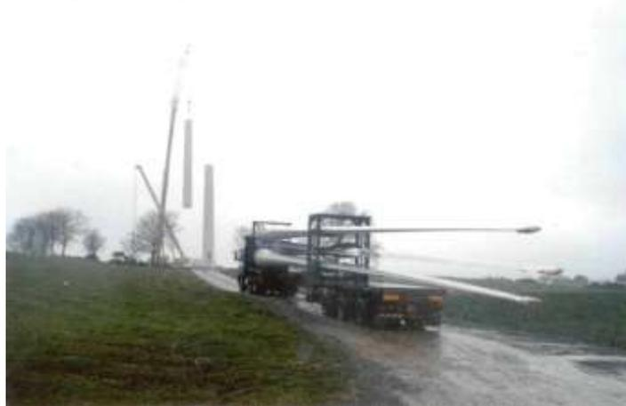
Figura 7.10 : Consegna delle pale e costruzione della torre
