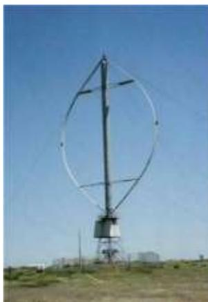
Figura 7.7 : Generatore eolico ad asse verticale Darrieus, Magdalen Island
